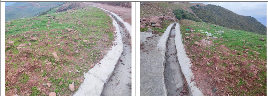
2#渣场排水设施 (2023.7)
