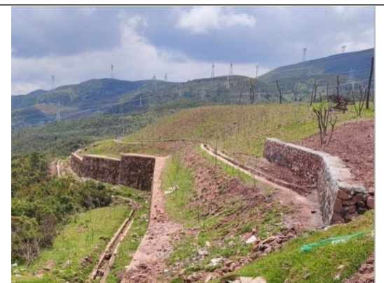
5#渣场挡护设施
