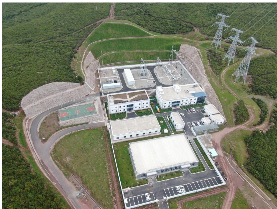
图 1-2 升压站现状航拍照片
