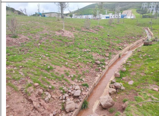
5#渣场排水设施
