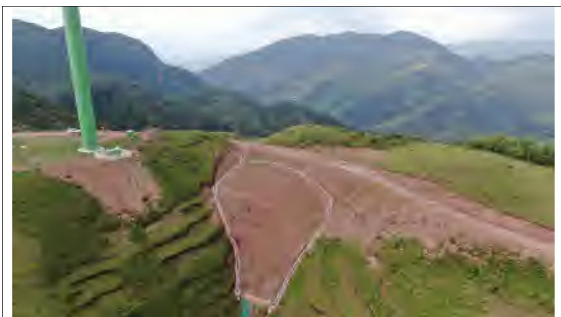
1#弃渣场航拍图（2023.7）
