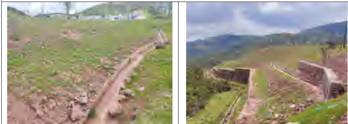
5#渣场排水设施
