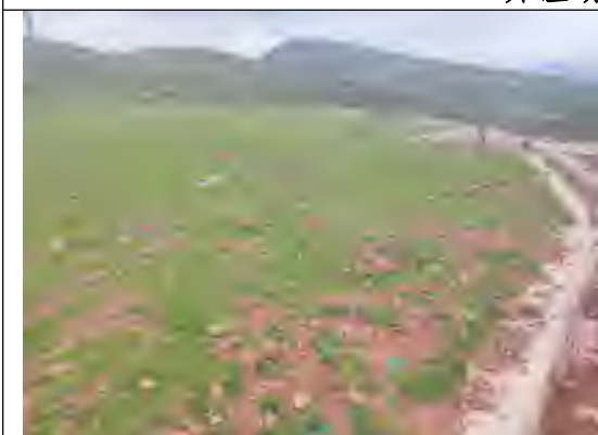
4#渣场排水设施 (2023.7)
