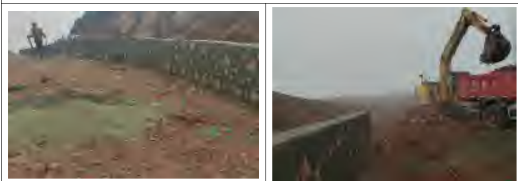
块石清理，用作浆砌石挡墙材料
