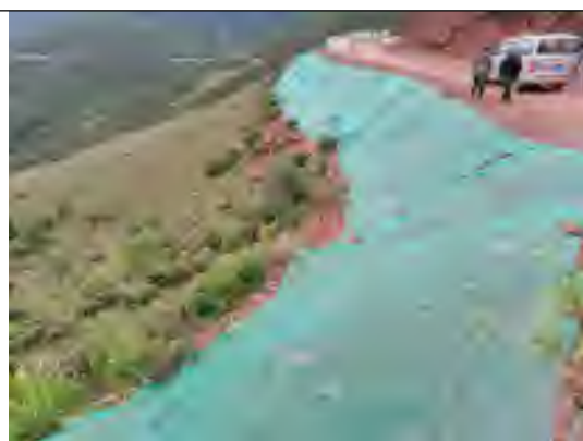
道路边坡盖土网遮盖（2021.9）
