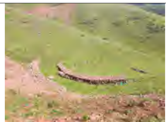
1#主线道路边坡干砌石挡墙（2023.7）
