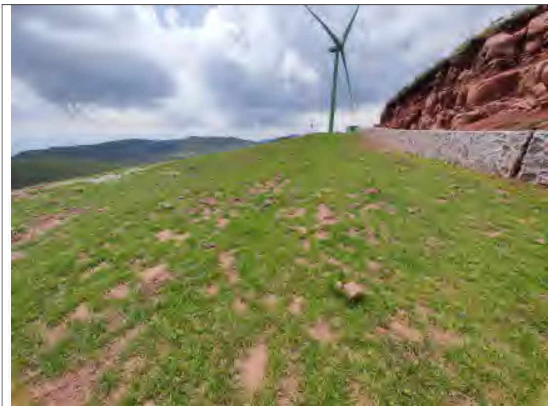
南区 2#主线道路，道路周边植被恢复及浆砌石挡墙（2023.7）
