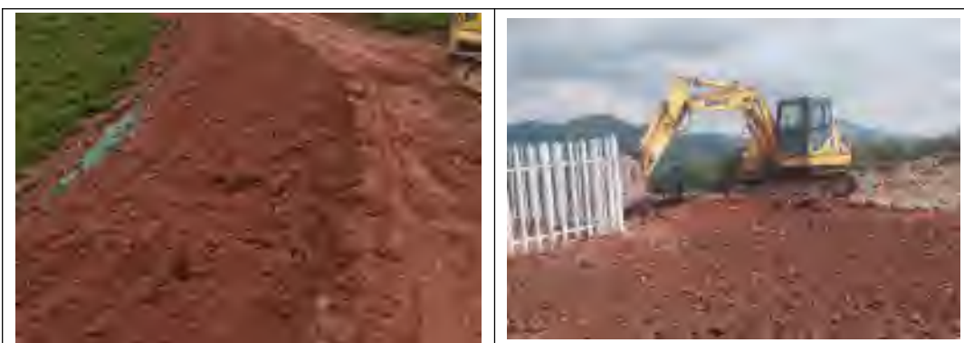
土地整治（施工中）（2022.7）
