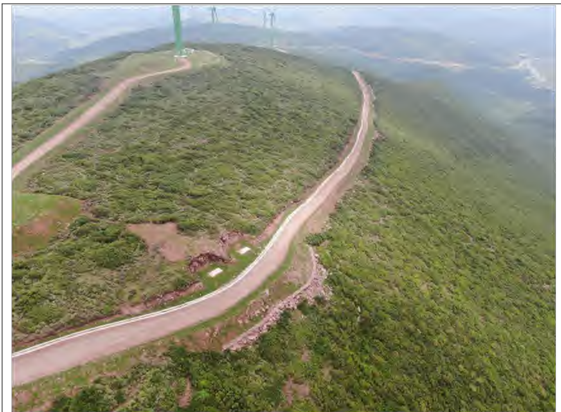
南区主线支线道路航拍图（2023.7）
