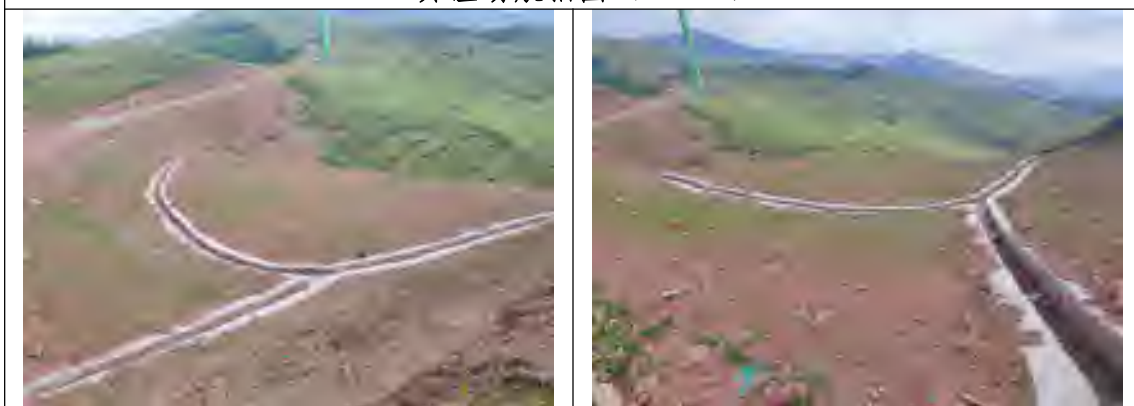
1#渣场排水设施及绿化（2023.7）
