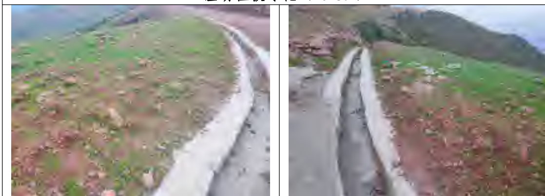
2#渣场排水设施 (2023.7)
