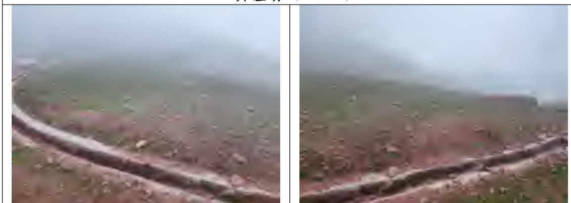
3#渣场排水设施 (2023.7)
